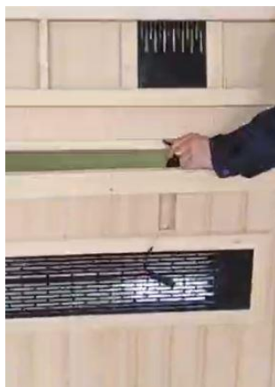
5. Umetnite kabel za povezivanje grijača u otvor na donjem dijelu stražnje ploče.
