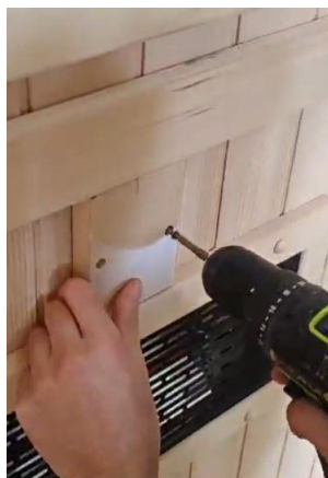
6. Spojite kable. Prekrijte luknje za povezavo grelcev z leseno ploščico in jo privijajte.
