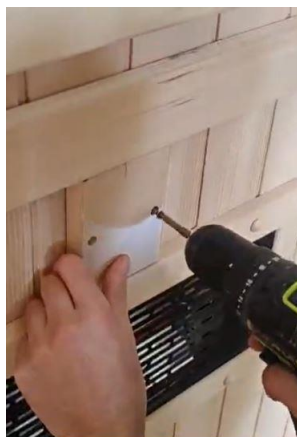
6. Spojite kabele. Prekrijite otvore za povezivanje grijača drvenom pločicom i pričvrstite je vijcima.
