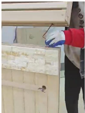
4. Utaknite kabel u donji dio leđa.
